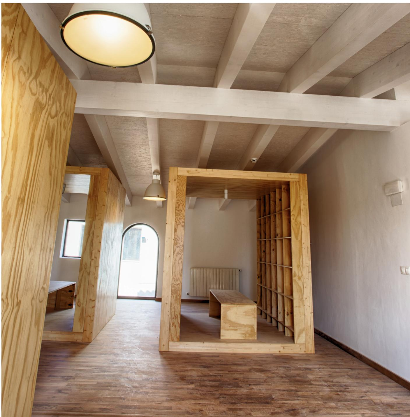
4,5 cm. Se colocan sobre las transversales a través de pasantes y tabla de pino de sección 12 x 2.8 cm., colocados mediante tirafondos.
