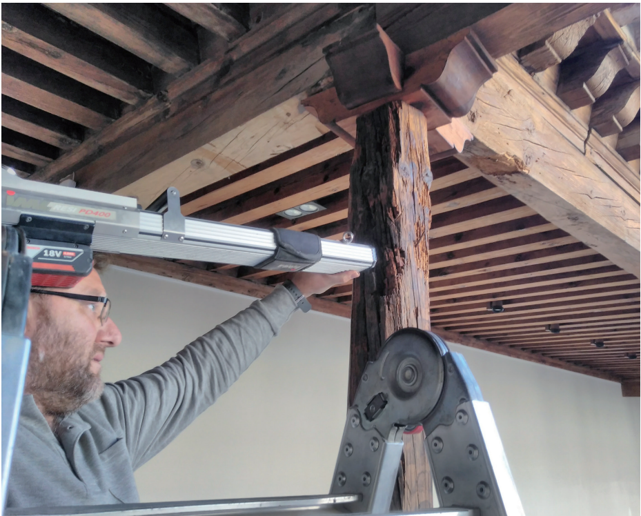
Ensayo no destructivo mediante resistografía en un elemento de madera antigua (siglo XVI).
