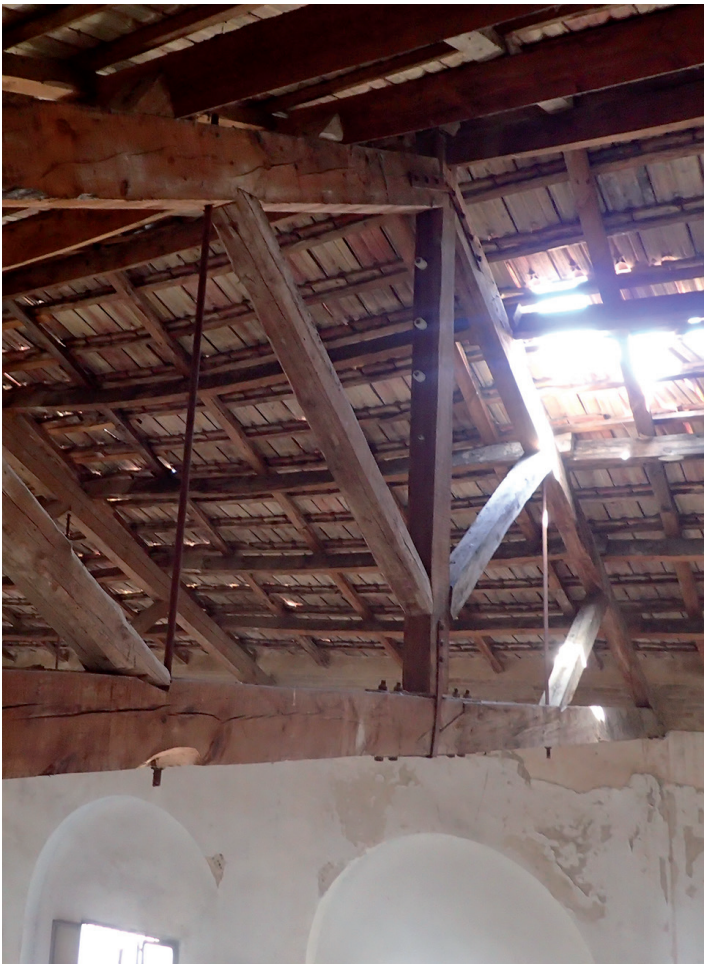
Estructura cerchada de cubierta hecha de madera de pinos locales ( Pinus halepensis y P. pinaster ).
